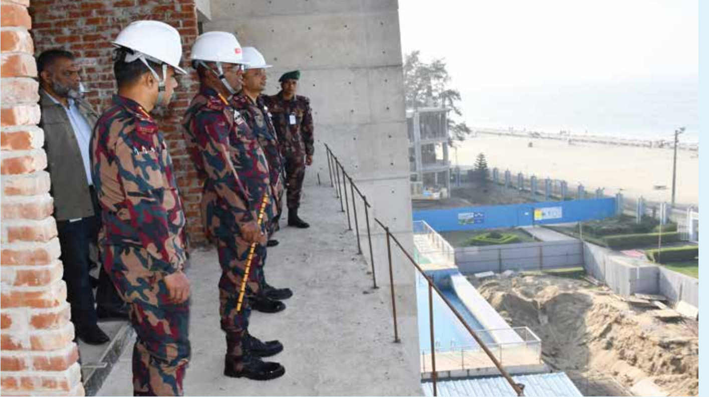
০৩ ফেব্রুয়ারি ২০২৩ তারিখে কক্সবাজারে নির্মাণাধীন 'বিজিবি উর্মি রেস্ট হাউজ' পরিদর্শন করেন বিজিবি মহাপরিচালক
